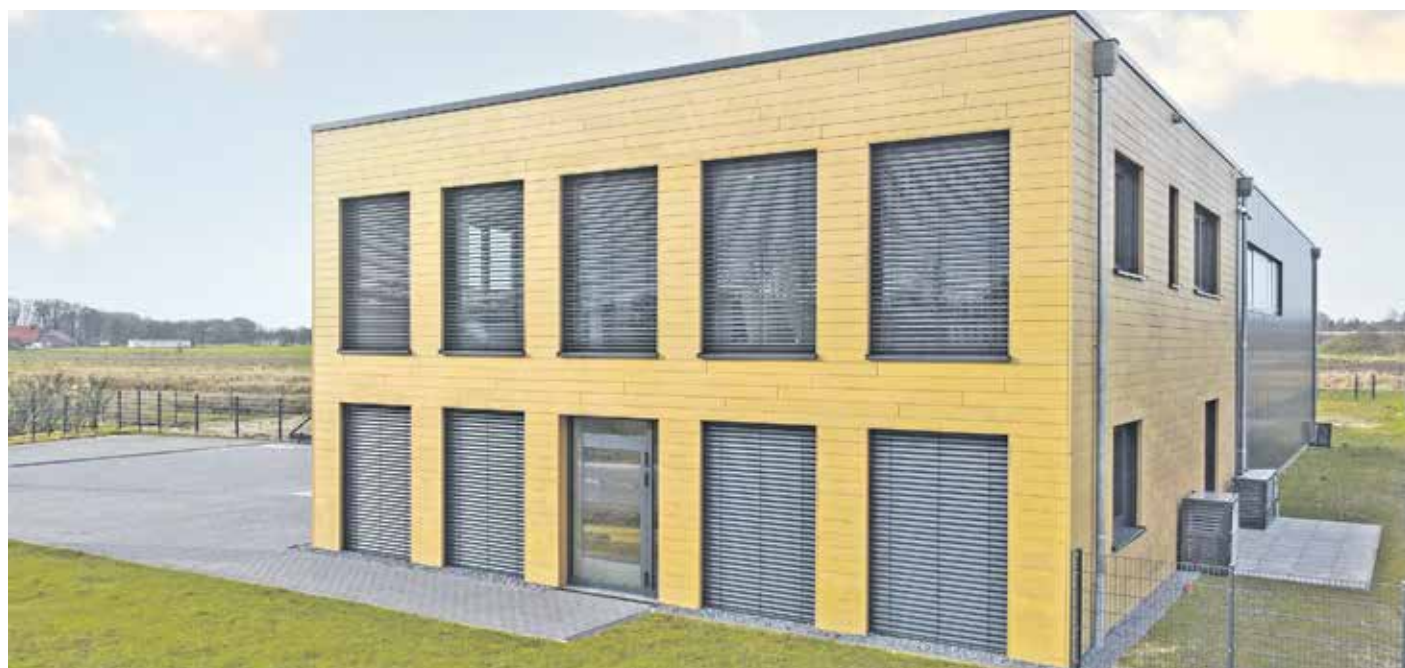
Der Verbundwerkstoff basiert auf Naturfasern und bietet zahlreiche Möglichkeiten für eine besondere Fassadengestaltung. Foto: DJD/www.megawood.com
